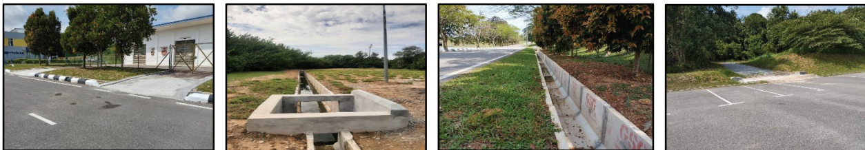
Pembinaan Longkang di Kampus Induk
