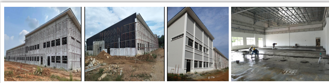
Kemajuan Semasa di Tapak Bina Bangunan Fakulti Teknologi Kejuruteraan
